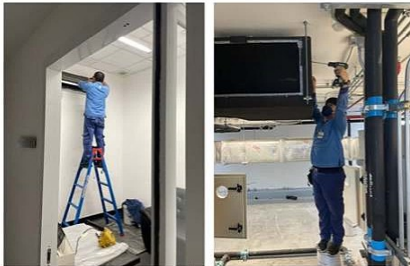
ภาพที่ 3-34 ล้างเครื่องปรับอากาศ ภายในอาคาร
