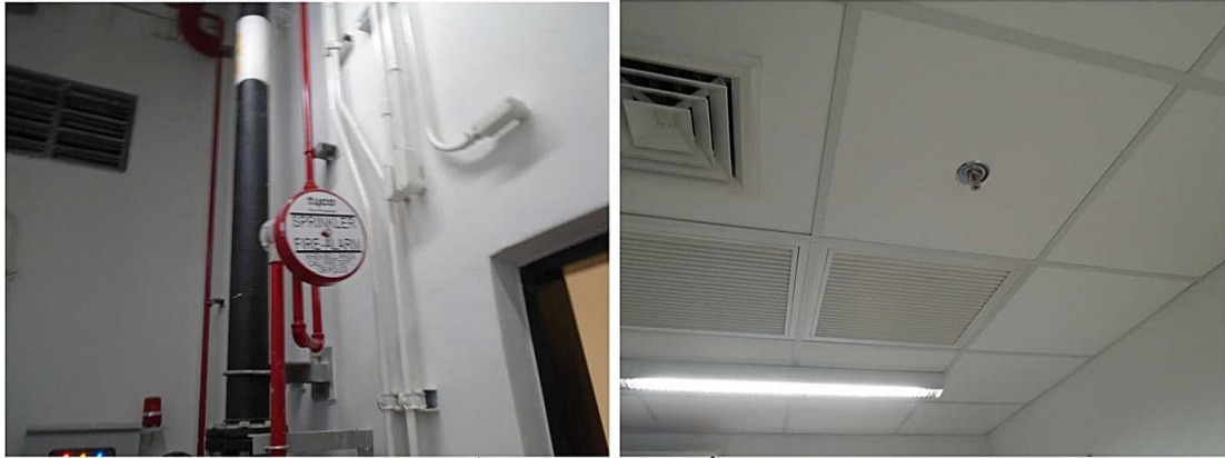
ภาพที่ 3-16 ระบบหัวกระจายน้ำดับเพลิง
