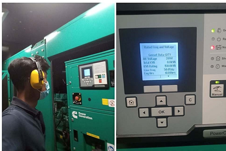
ภาพที่ 3-12 ห้องเครื่องไฟฟ้าฉุกเฉิน บุด้วยวัสดุกันเสียงและการทดสอบประจำสัปดาห์
