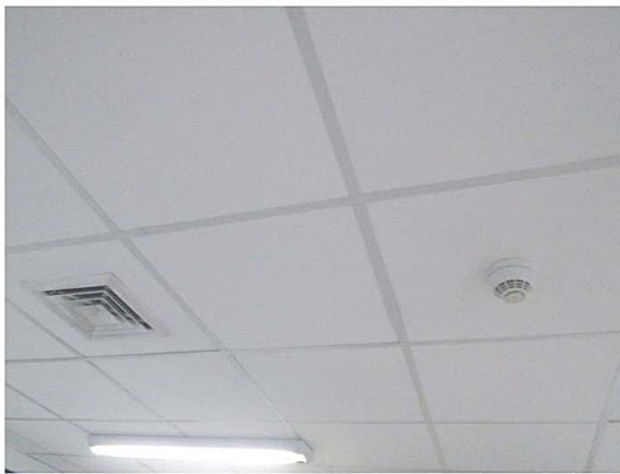
ภาพที่ 3-20 เครื่องตรวจจับควันภายในโครงการ
