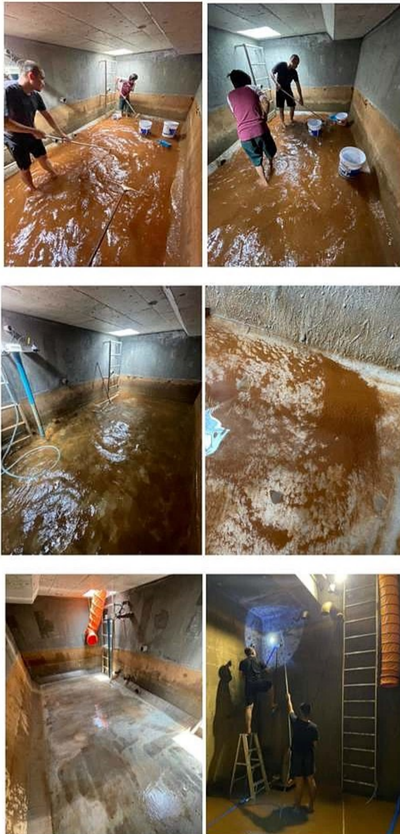
ภาพที่ 3-38 สร้างถังสำรองน้ำใต้ดิน
